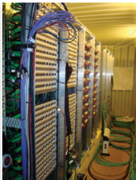
Фото 8. Контейнер DSG с более чем 90 каналами для новостных комплектов и спутниковых терминалов
