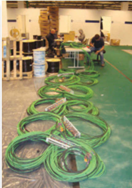
Фото 2. Сборка части коммутационных панелей для каждого из 160 журналистских рабочих мест
